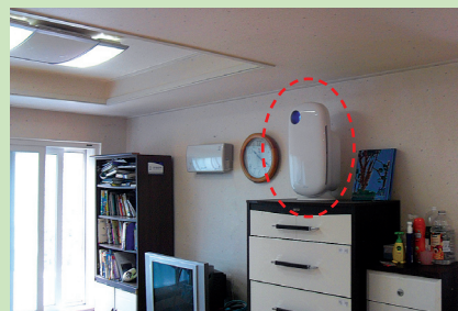
(나) 설치 후
